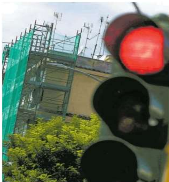
Un'impalcatura per i lavori di ristrutturazione di un condominio
